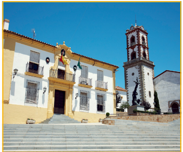
▶ Ayuntamiento de Fuente Ovejuna (Córdoba).
